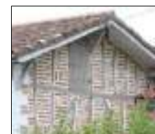
Structure en pans de bois, briques et joints sable-chaux Source : L'Artifex
