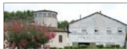
Bâtiments des Grands Armagnacs Source : L'Artifex
