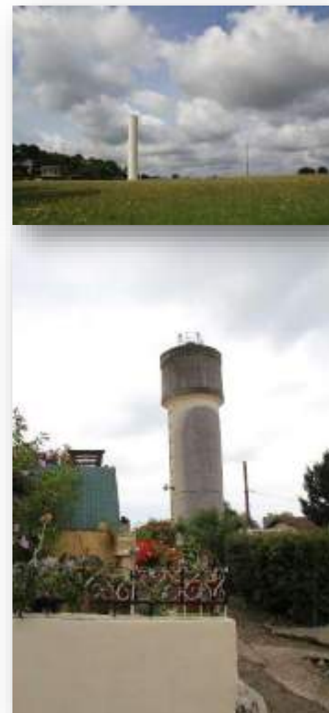
Figure 81 : châteaux d'eau de Castelnau d'Auzan Labarrère, source : Paysages
