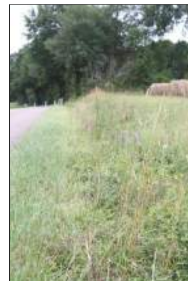
Fossé récemment débroussaillé Source : L'Artifex
