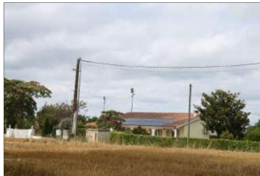
Exemple de panneaux photovoltaïques sur toiture à Castelnaud d'Auzan Labarrère Source : L'Artifex
